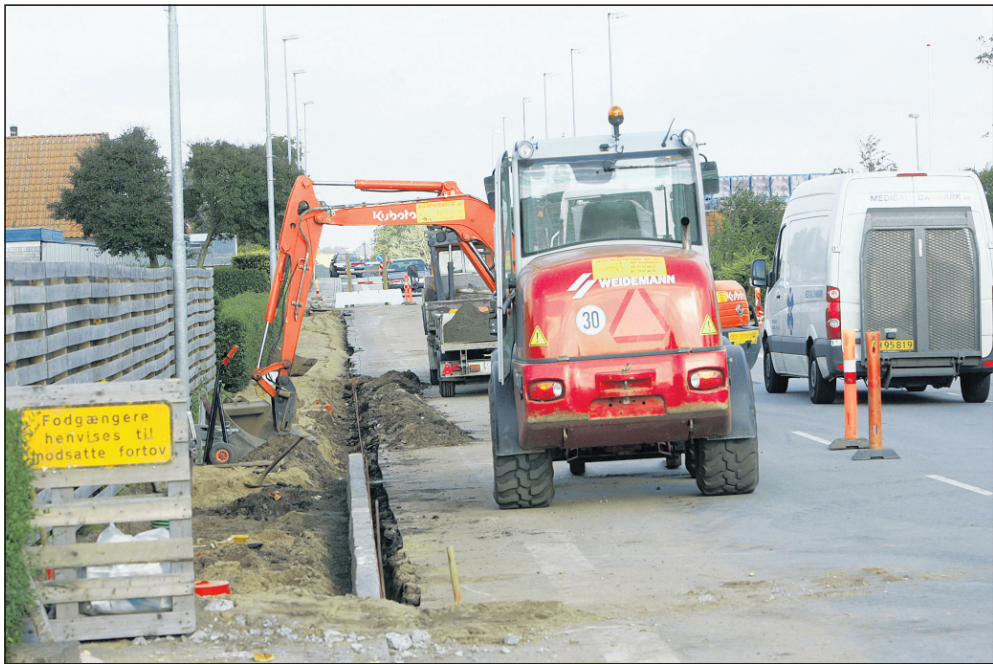
NYE RØR PÅVIRKER TRAFIKKEN • Højslev - Nr. Søby fjernvarme er ved at udskifte 100 meter varmerør mellem værket i Højslev og Nr. Søby. Det betyder, at der er gravet op, og at trafikken ad Viborgvej er generet. Højslev - Nr. Søby Fjernvarme forventer, arbejdet er slut i næste uge. Foto: Casper Jacobsen
